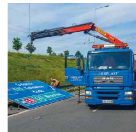
Wymiana tablic drogowych przed otwarciem węzła autostradowego Łódź Północ. Na ciągu głównym A1 montowane znaki Wielkie „eksperymentalne”, natomiast na A2 zamontowano tablice Wielkie „standardowe”. Celem było zachowanie ciągłości rodzaju oznakowania.
