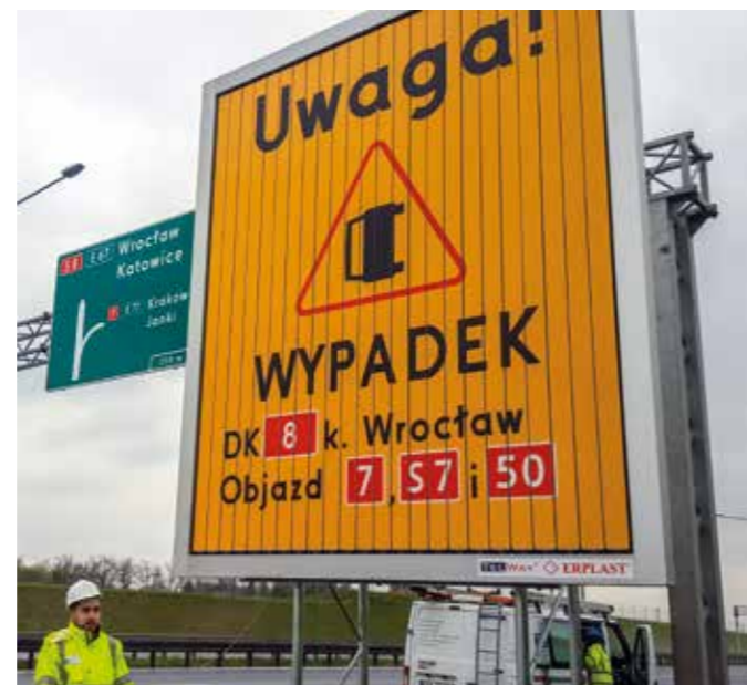
Pryzmowa tablica ostrzegawcza o utrudnieniach związanych z budową drogi S8. Tablica pryzmowa zamontowana na zlecenie Telway. Dwie tablice o wymiarach 2,5 x 3,0 m. Tablice zasilane ogniwem fotowoltaicznym. Sterowanie za pomocą aplikacji przeglądarkowej oraz mobilnej.
