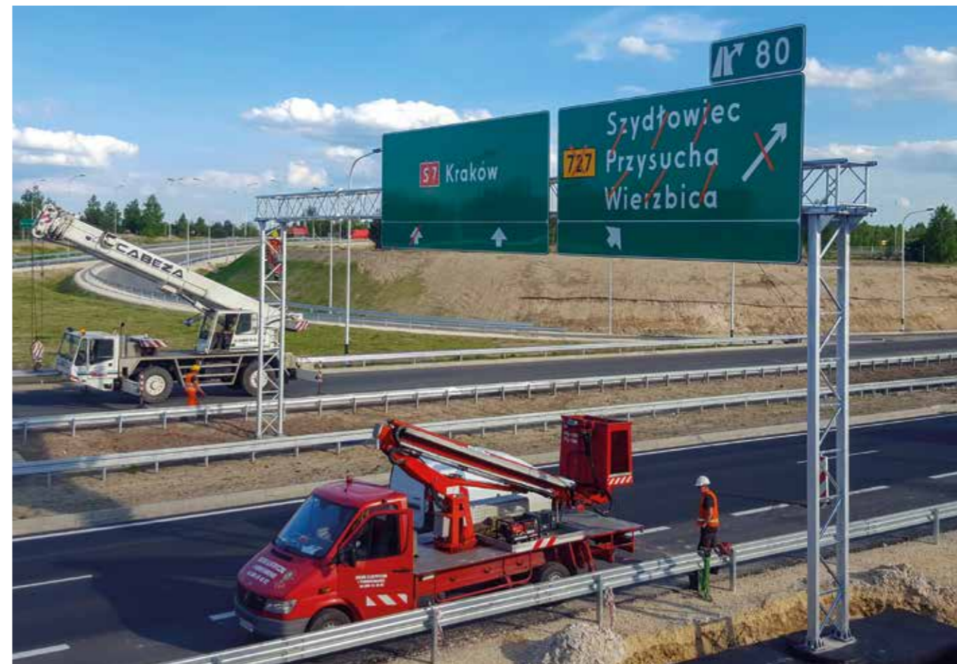
Zdjęcia przedstawiają bramownicę na drodze S7. Obwodnica Szydłowca.
