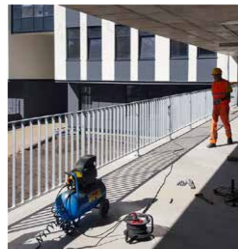
Montaż balustrad na parkingu wielopoziomym w Warszawie.
