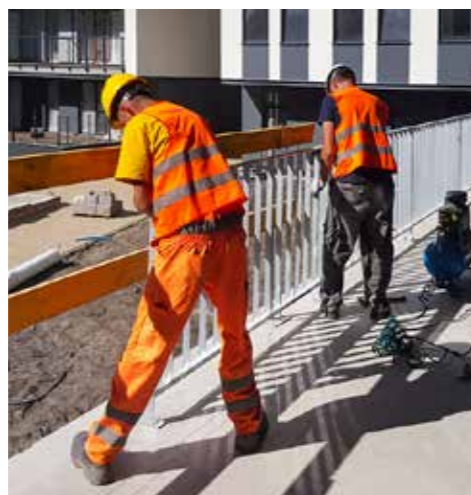
Montaż balustrad na parkingu wielopoziomym w Warszawie.
