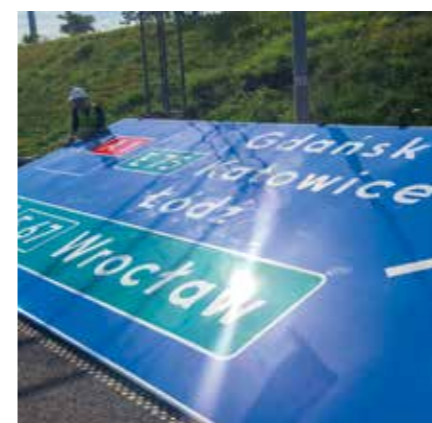
Wymiana tablic drogowych przed otwarciem węzła autostradowego Łódź Północ. Na ciągu głównym A1 montowane znaki Wielkie „eksperymentalne”, natomiast na A2 zamontowano tablice Wielkie „standardowe”. Celem było zachowanie ciągłości rodzaju oznakowania.
