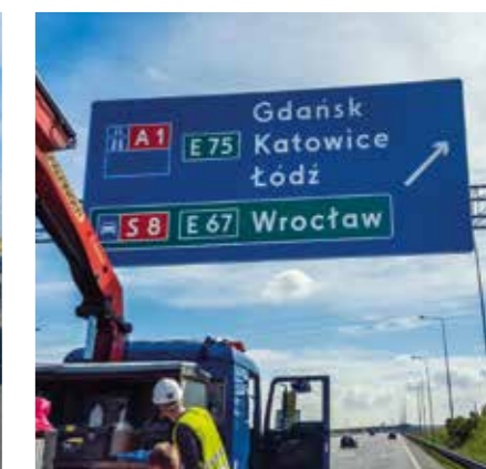
Wymiana tablic drogowych przed otwarciem węzła autostradowego Łódź Północ. Na ciągu głównym A1 montowane znaki Wielkie „eksperymentalne”, natomiast na A2 zamontowano tablice Wielkie „standardowe”. Celem było zachowanie ciągłości rodzaju oznakowania.
